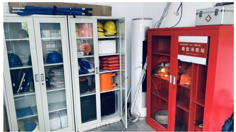
厂内应急物资柜和微型消防站
